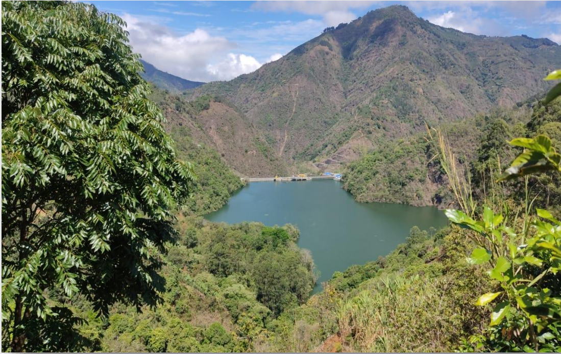
Figura 1.1 Tarrazú: Represa Hidroeléctrica del Río Pirrís, distrito San Carlos
