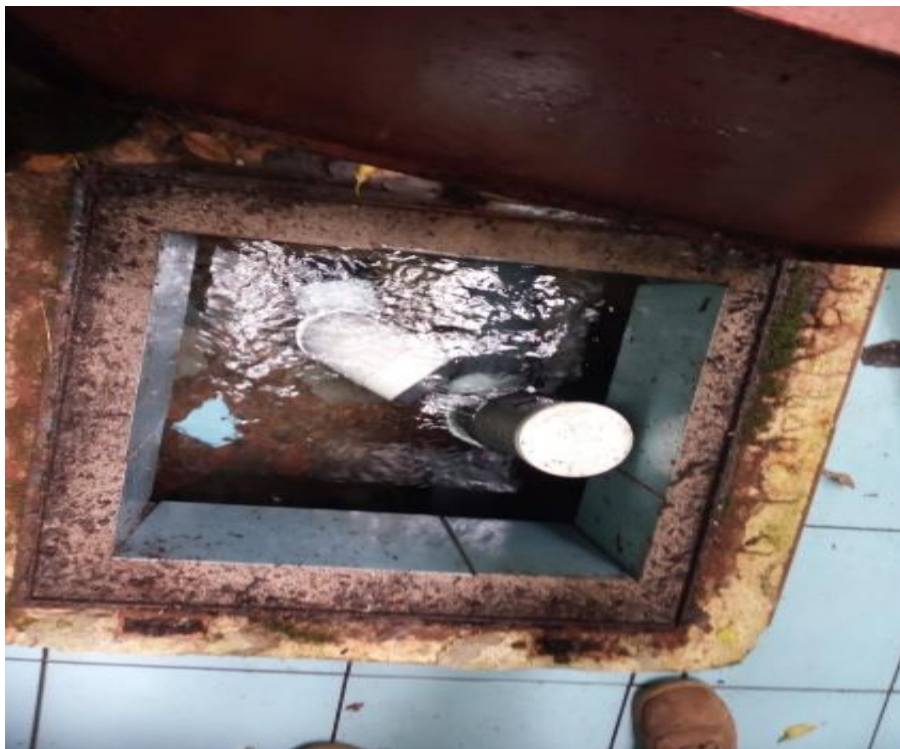
Ilustración 30. Heredia, Tanques y casetillas de cloración Vara Blanca, Heredia.
