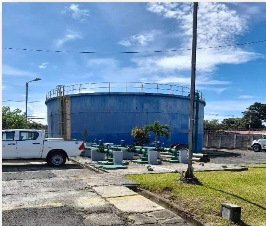
Ilustración 13. Tanque Carbonal, Mercedes Norte. Volumen 2000 m3, toma frontal.
