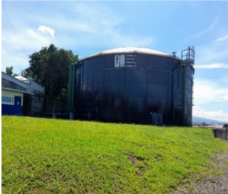
Ilustración 14. Tanque Carbonal, Mercedes Norte. Volumen 2000 m3, toma frontal.
