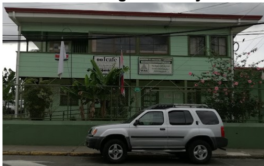
Figura N.º 35 Edificio del MAG en Palmares
