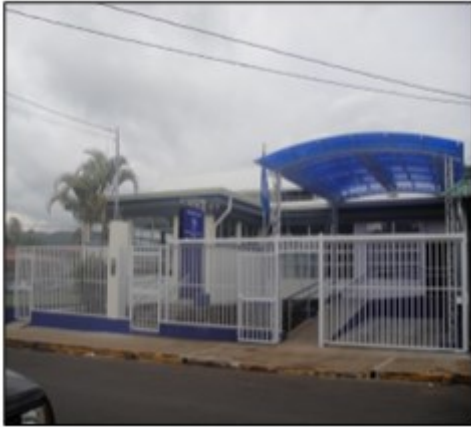
Figura N.º 38 Edificio del Área Rectora de Salud Palmares
