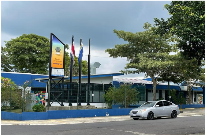
Figura N.º 13 Instalaciones de la UNED Palmares
