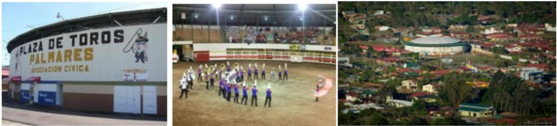
Figura N.º 36 Infraestructura ACP
