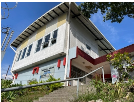
Figura 58 Instalaciones de la Biblioteca pública de Palmares
