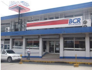
Figura N.º 27 Instalaciones del BCR en Palmares
